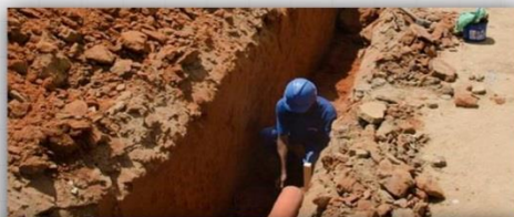
DRENAGEM E PAVIMENTAÇÃO
