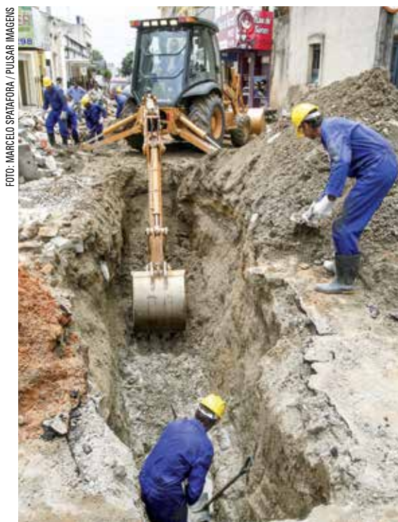
OBRA PARA INSTALAÇÃO DA REDE DE ESGOTO NA PERIFERIA DE MARANGUAPE-CE
