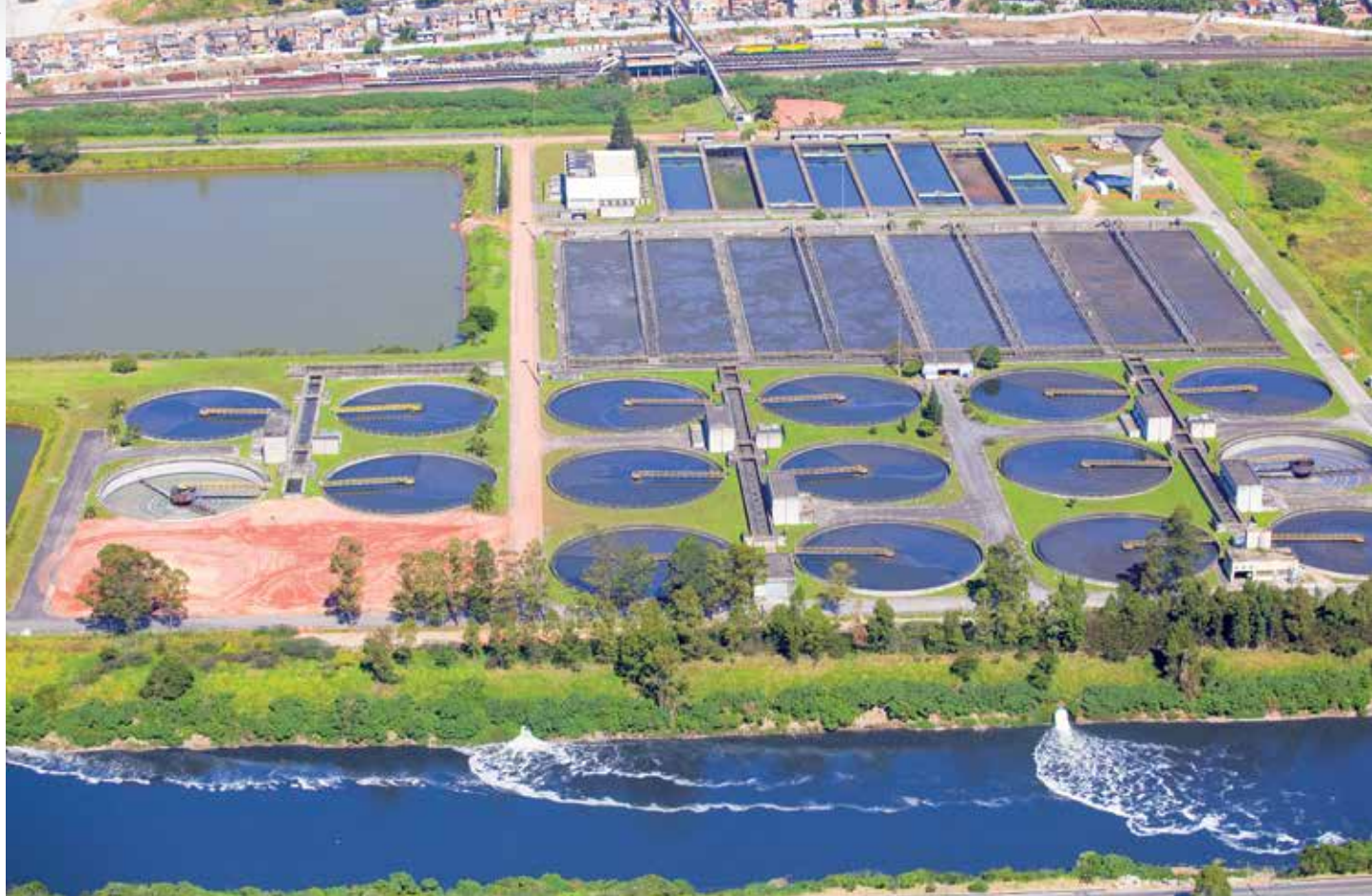
ESTAÇÃO DE TRATAMENTO DE ESGOTOS NOVA ALDEINHA EM CARAPICUÍBA-SP
