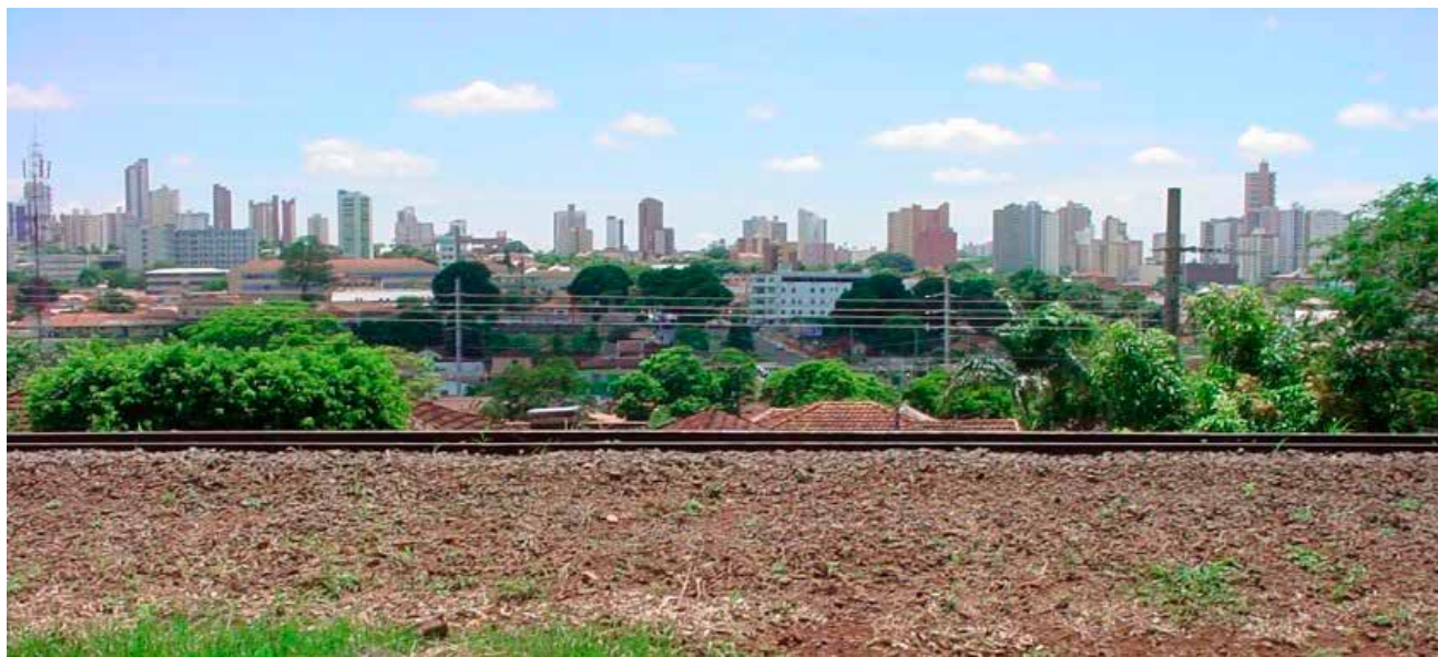
Foto 1: Trecho da área do Orla Morena antes da intervenção
